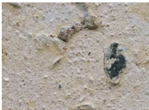
Enduit à pierre vue
